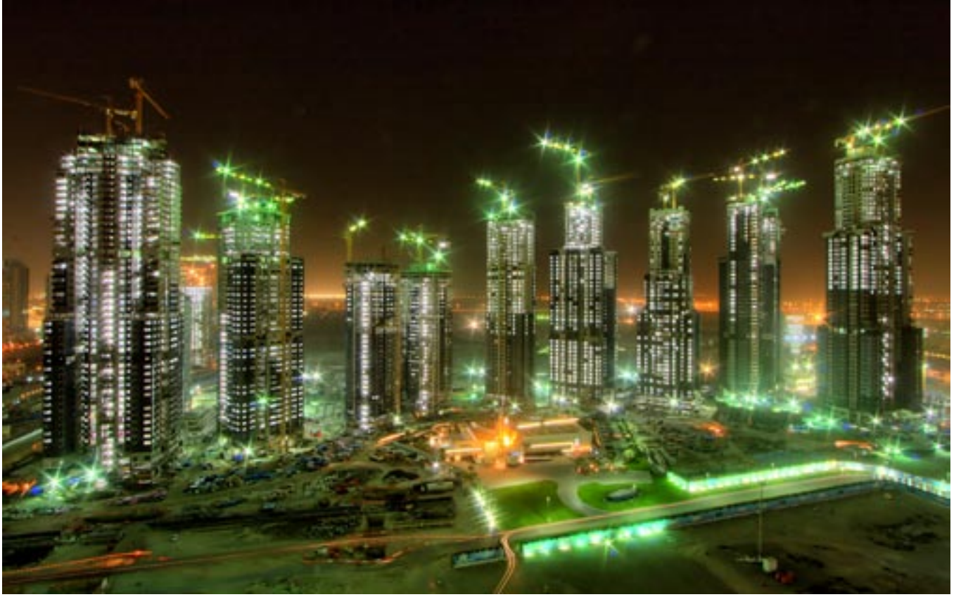
واحد من مشروعات البناء العديدة في دبي.
